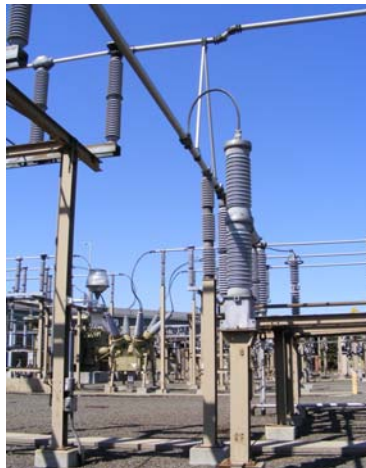
Fig. 20. 345 kV CCVT
