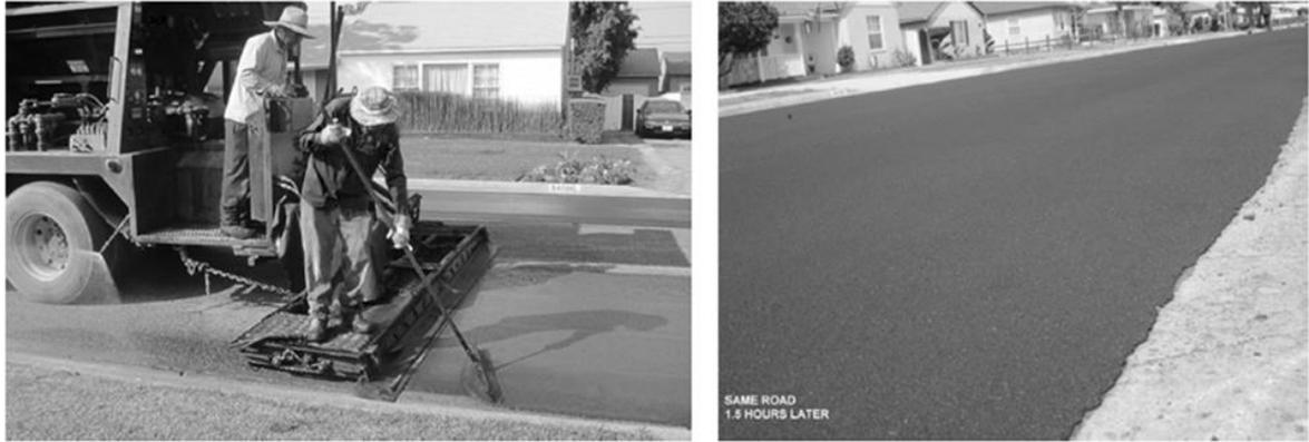
*Figure 54 Slurry Seal*
