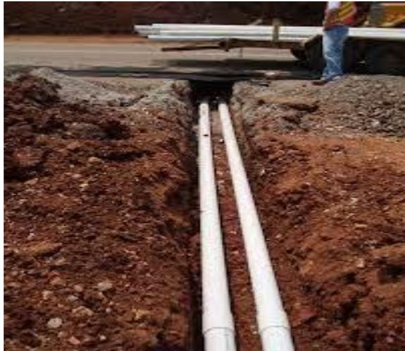
*Figure 96 Retrofitted Edge Drains*
