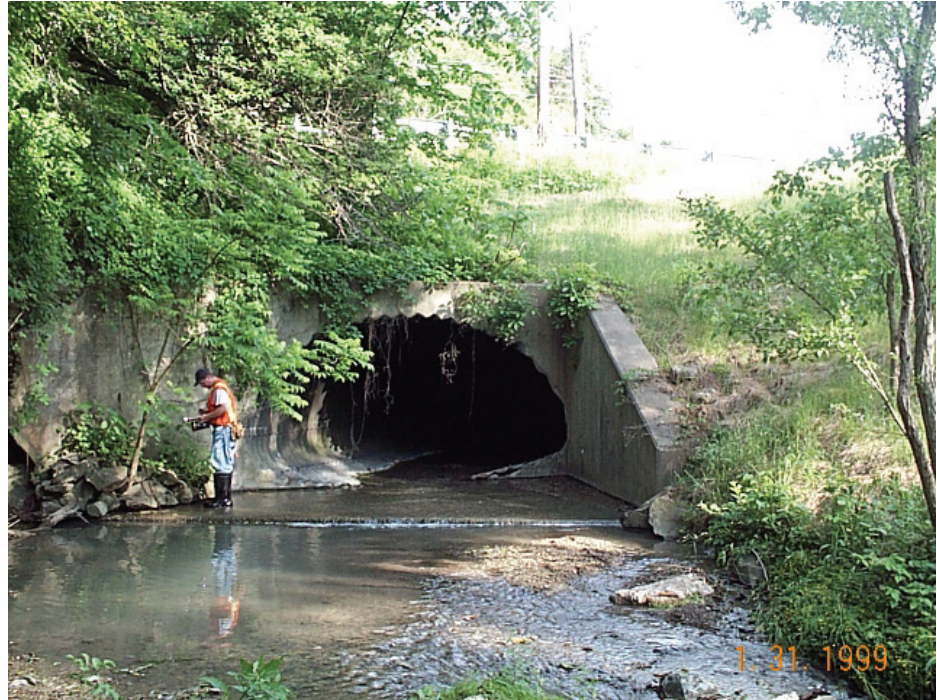
Figure P.3.19 Apron
