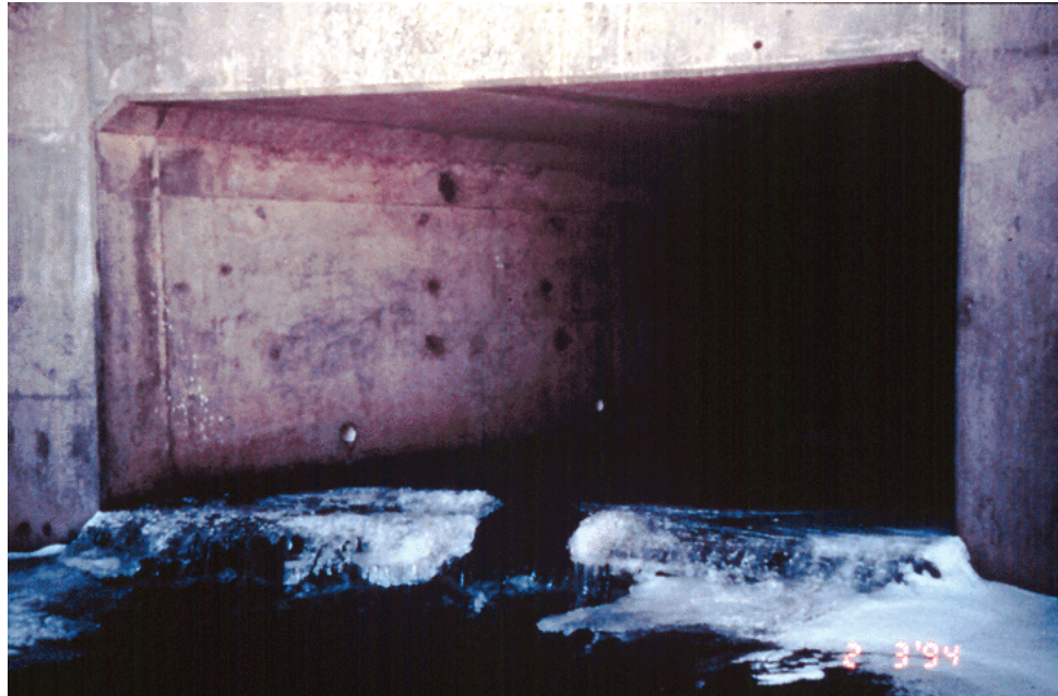
Figure P.3.33 Apron
